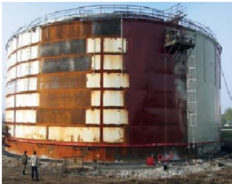
Рисунок 1 - PVC-10000 Радаевской УПН с зачищенными участками
