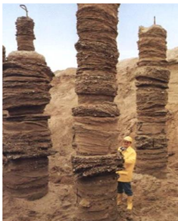
Рис. 1. Грунтоцементные сваи
