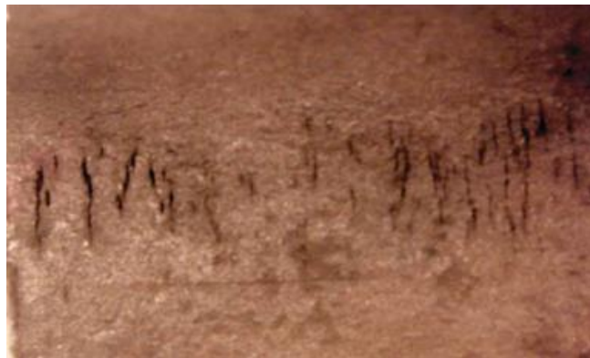
Рис.2. Трещины под воздействием напряжений
