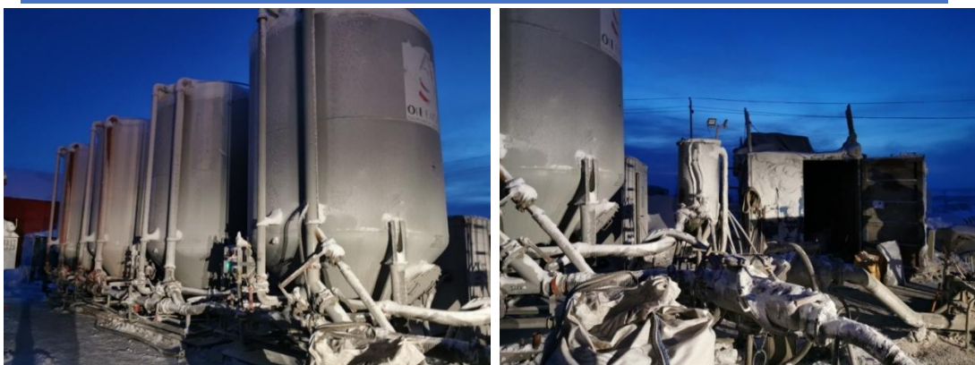
Рисунок 5, 6 – Общий вид цементного завода сервисного подрядчика №2
