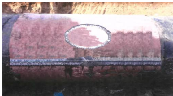
Рисунок 3.1. Ремонтная заплата с муфтой П2
