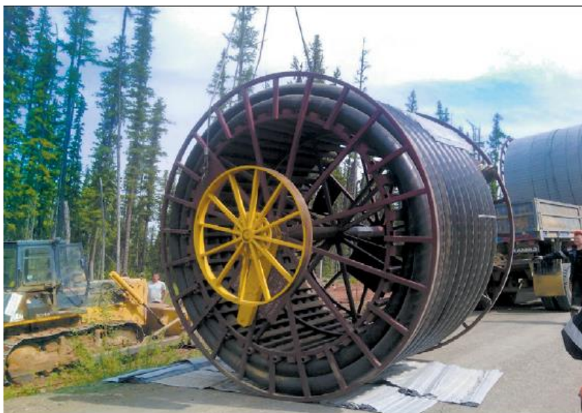
Рисунок 3 – сборка ПАТ на транспортировочном барабане.
